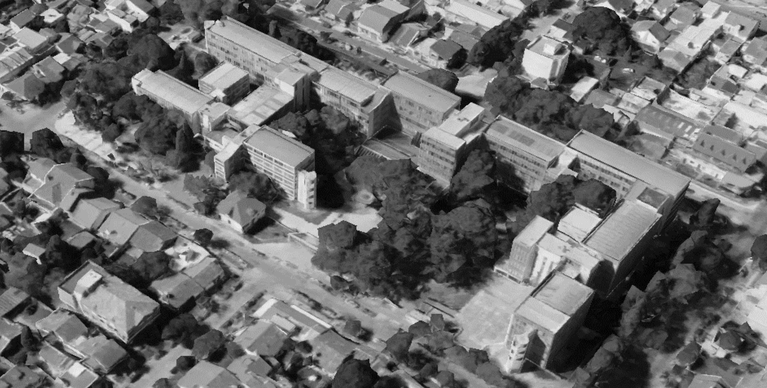
COMPLEJO UNIVERSITARIO MANUEL BELGRANO PUESTA EN VALOR POR ETAPAS DE CUBIERTAS, SANITARIOS, INSTALACIONES Y PINTURA DE ESPACIOS INTERIORES
